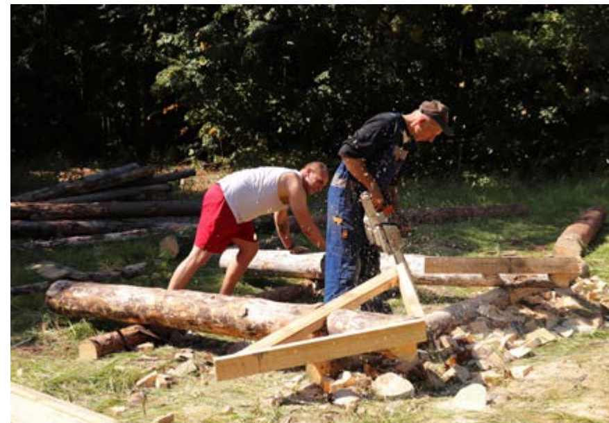
Строительство солонцов, фото Ивана Крикуна
